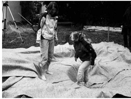
Viel "Fußarbeit" war erforderlich, um die Vlies und Teichfolie möglichst faltenfrei zu verlegen.
